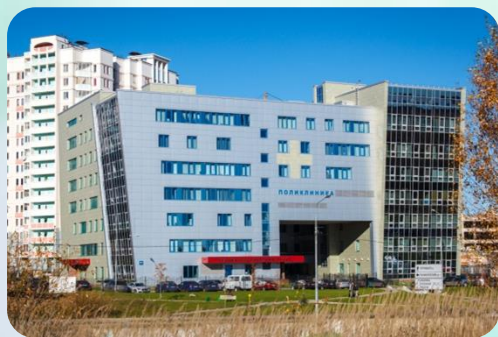
ГБУЗ ГП № 201 (новое здание корп. 2042)
